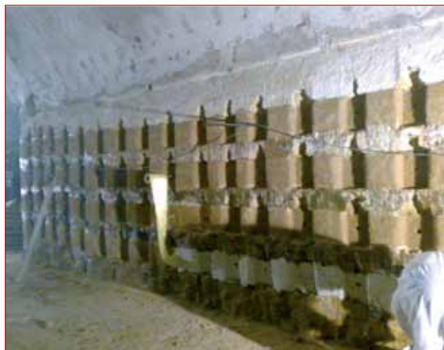
Consolidamento "Real Albergo dei Poveri" Napoli
