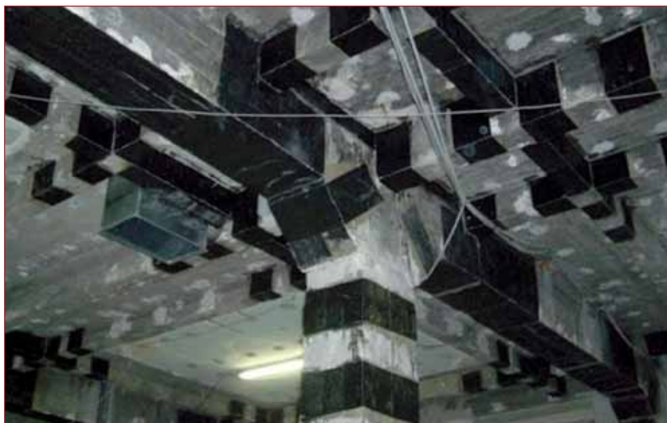
Rinforzo "Atlantic Hotel Boscolo" Nizza (F) /
