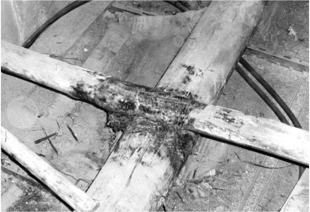
Fig. 1-2. Particolari del collegamento fra ginella rompitratta e travi principali, ripristinato con tessuti bidirezionali in CFRP in sostituzione delle antiche strasciolette metalliche
