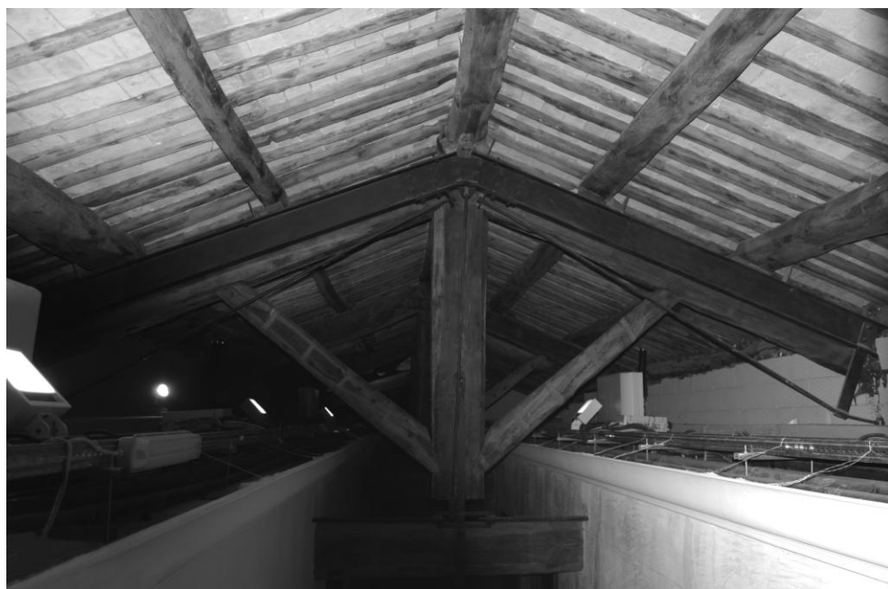
Fig. 3. Roma, ex-Granaio Clementino, copertura, particolare capriata n. 11, lato nord. In primo piano il sistema collaborante in acciaio con tiranti e profilati, apprestato precedentemente all'intervento con CFRP.
