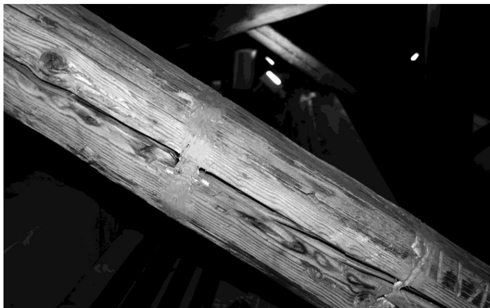
Fig. 4. Roma, ex-Granaio Clementino, tetto, capriata n. 12, particolare del saettone e del cerchiaggio in CFRP.
