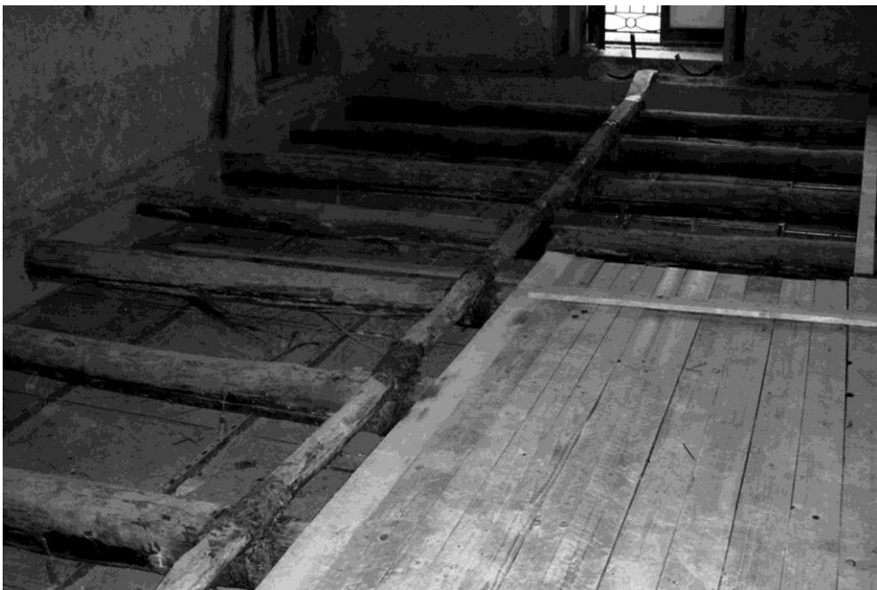
Fig. 1-2. Particolari del collegamento fra ginella rompitratta e travi principali, ripristinato con tessuti bidirezionali in CFRP in sostituzione delle antiche strasciolette metalliche
